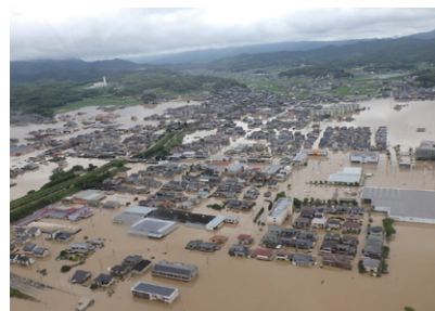
岡山県倉敷市真備町 （東京消防庁提供）
